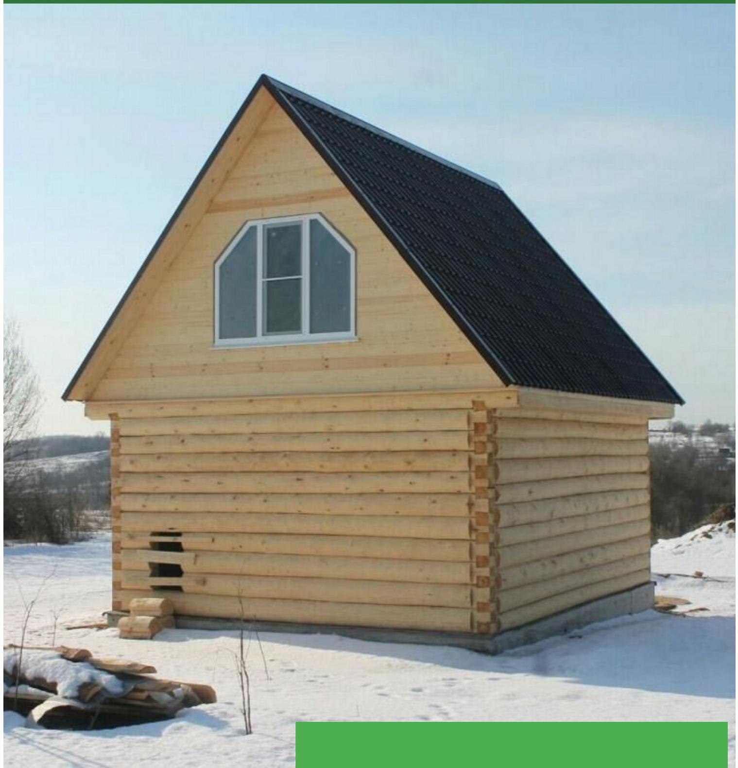
В комплекте: половые лаги, потолочные перекрытия, фронтоны защиты обрезным материалом или вагонкой, крыша кроется рубероидом на время усадки сруба, межвенцовый утеплитель мох, гвозди, рубероид
