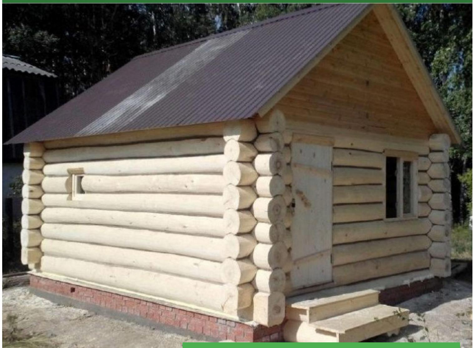
В комплекте: половые лаги, потолочные перекрытия, фронтоны защиты обрезным материалом или вагонкой, крыша кроется рубероидом на время усадки сруба, межвенцовый утеплитель мох, гвозди, рубероид
