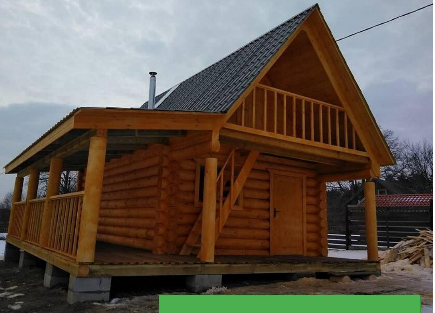
В комплекте: половые лаги, потолочные перекрытия, фронтоны защиты обрезным материалом или вагонкой, крыша кроется рубероидом на время усадки сруба, межвенцовый утеплитель мох, гвозди, рубероид
