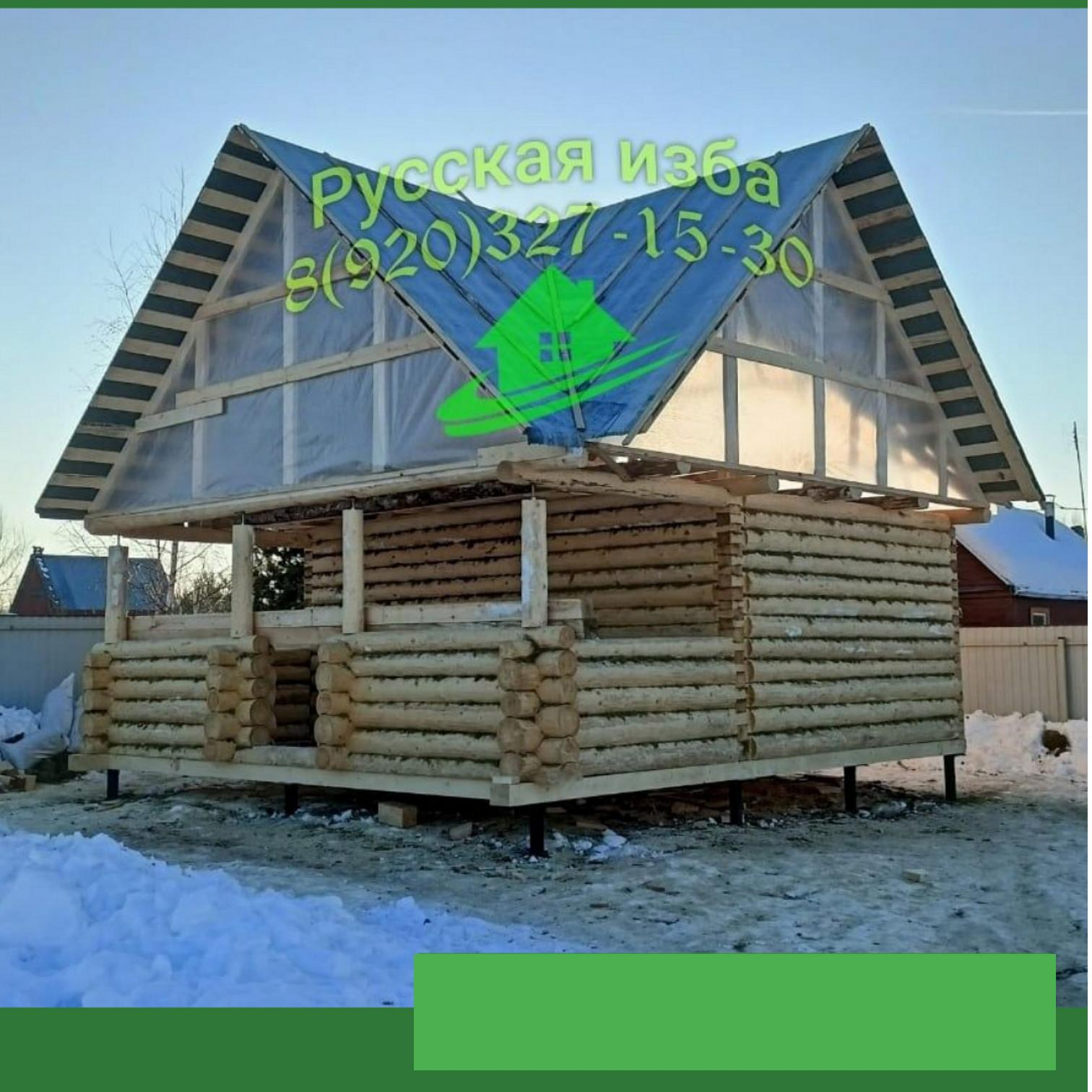
В комплекте: половые лаги, потолочные перекрытия, фронтоны зашиты обрезным материалом или вагонкой, крыша кроется рубероидом на время усадки сруба, межвенцовый утеплитель мох, гвозди, рубероид
