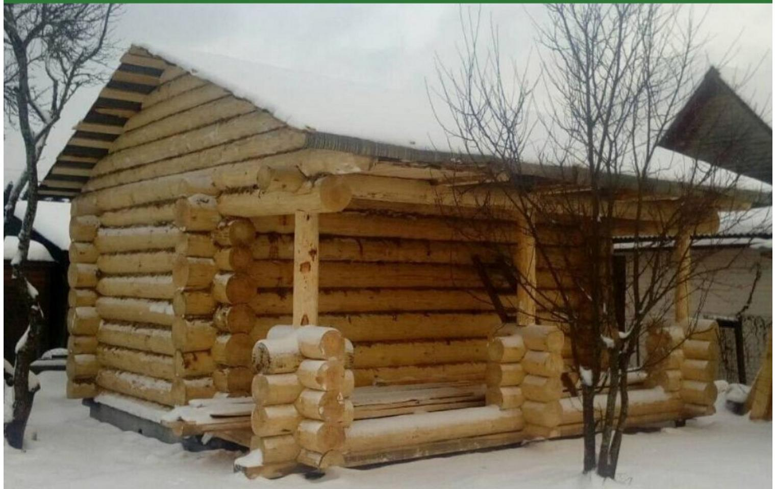
В комплекте: половые лаги, потолочные перекрытия, фронтоны зашиты обрезным материалом или вагонкой, крыша кроется рубероидом на время усадки сруба, межвенцовый утеплитель мох, гвозди, рубероид
