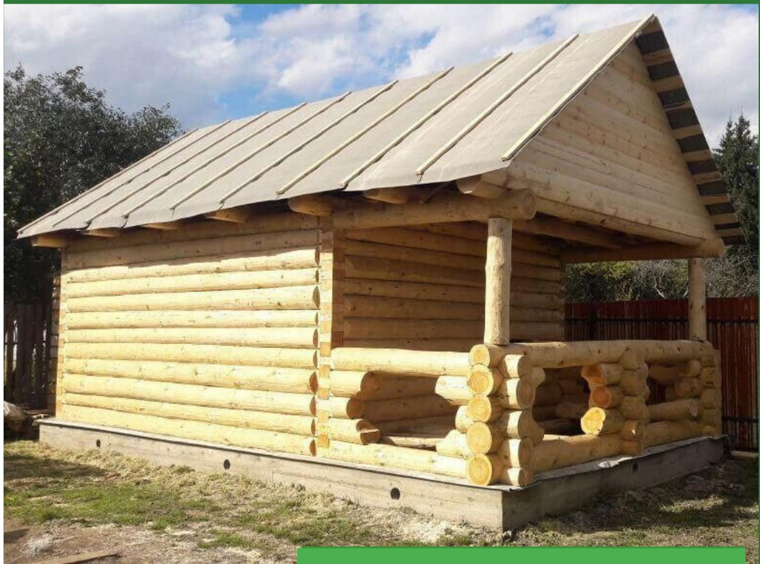
В комплекте: половые лаги, потолочные перекрытия, фронтоны зашиты обрезным материалом или вагонкой, крыша кроется рубероидом на время усадки сруба, межвенцовый утеплитель мох, гвозди, рубероид
