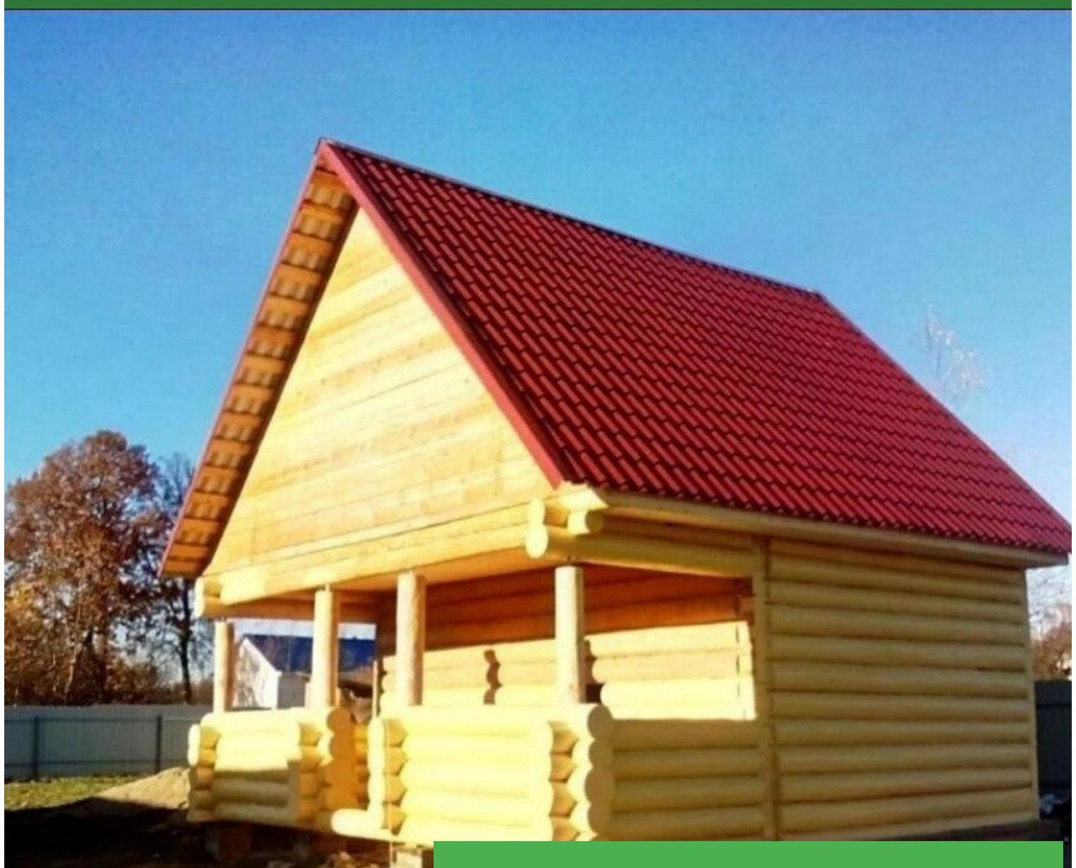
В комплекте: половые лаги, потолочные перекрытия, фронтоны зашиты обрезным материалом или вагонкой, крыша кроется рубероидом на время усадки сруба, межвенцовый утеплитель мох, гвозди, рубероид
