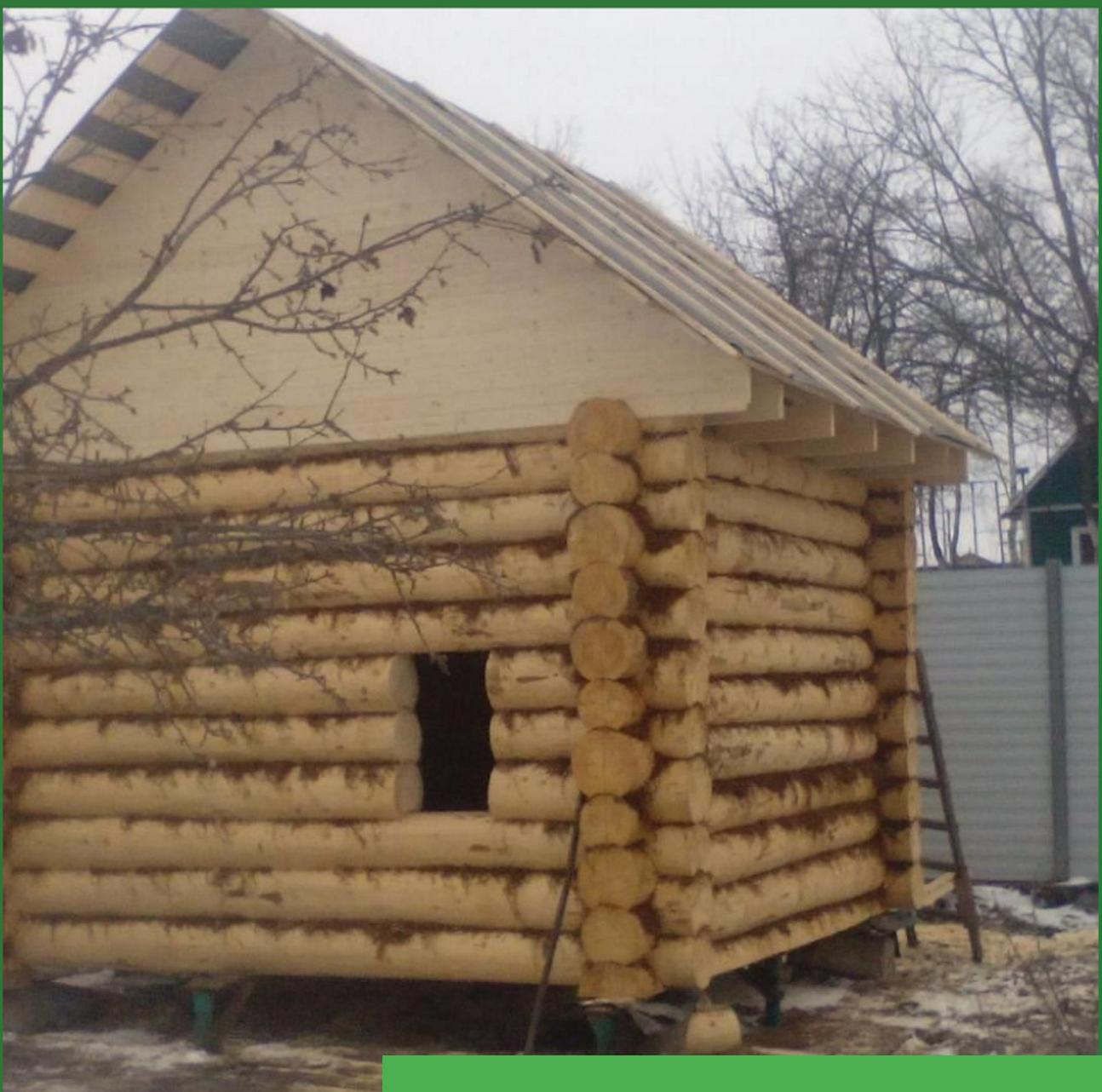
В комплекте: половые лаги, потолочные перекрытия, фронтоны защиты обрезным материалом или вагонкой, крыша кроется рубероидом на время усадки сруба, межвенцовый утеплитель мох, гвозди, рубероид
