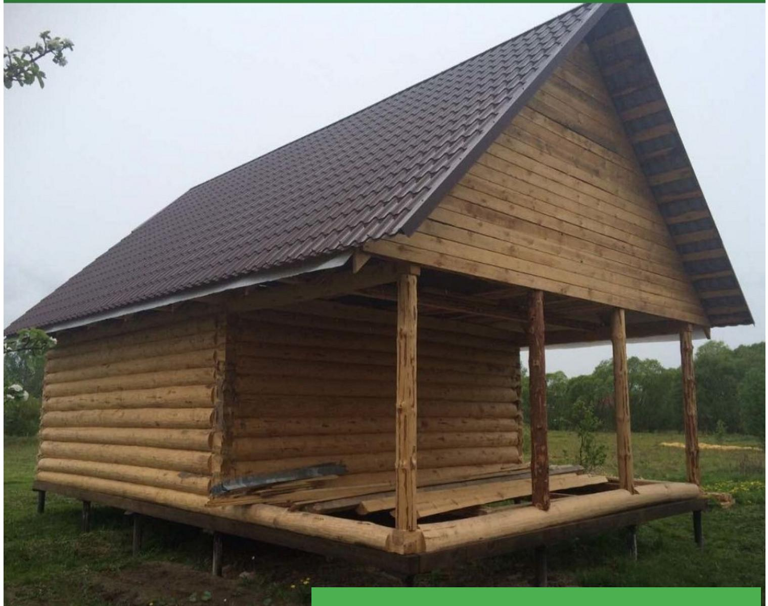
В комплекте: половые лаги, потолочные перекрытия, фронтоны защиты обрезным материалом или вагонкой, крыша кроется рубероидом на время усадки сруба, межвенцовый утеплитель мох, гвозди, рубероид
