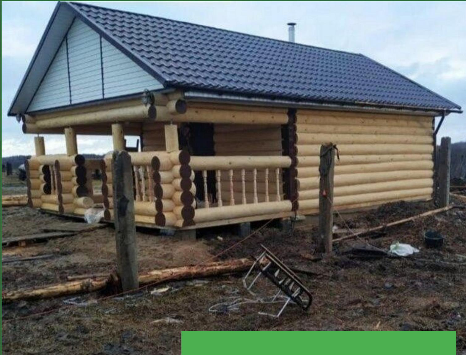
В комплекте: половые лаги, потолочные перекрытия, фронтоны зашиты обрезным материалом или вагонкой, крыша кроется рубероидом на время усадки сруба, межвенцовый утеплитель мох, гвозди, рубероид
