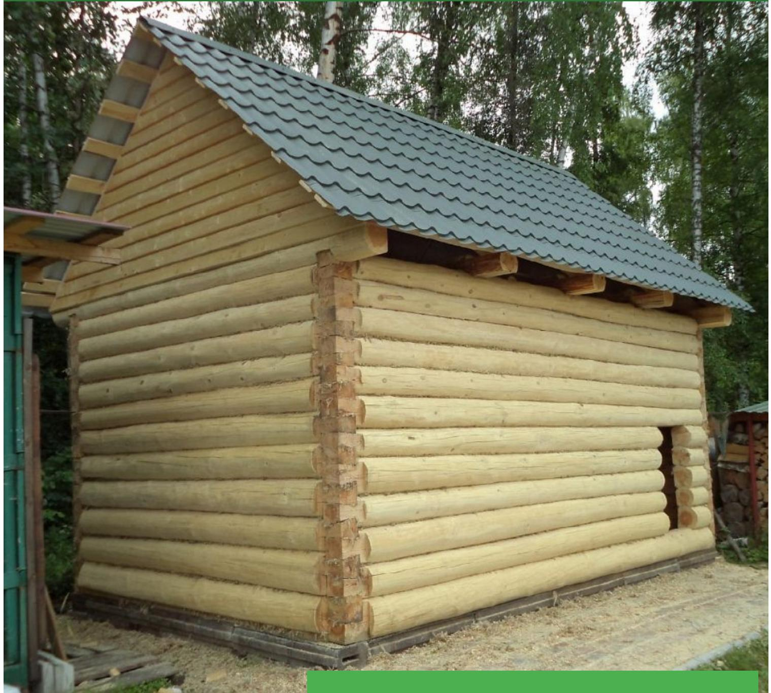
В комплекте: половые лаги, потолочные перекрытия, фронтоны защиты обрезным материалом или вагонкой, крыша кроется рубероидом на время усадки сруба, межвенцовый утеплитель мох, гвозди, рубероид
