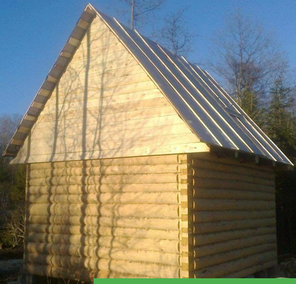
В комплекте: половые лаги, потолочные перекрытия, фронтоны защиты обрезным материалом или вагонкой, крыша кроется рубероидом на время усадки сруба, межвенцовый утеплитель мох, гвозди, рубероид
