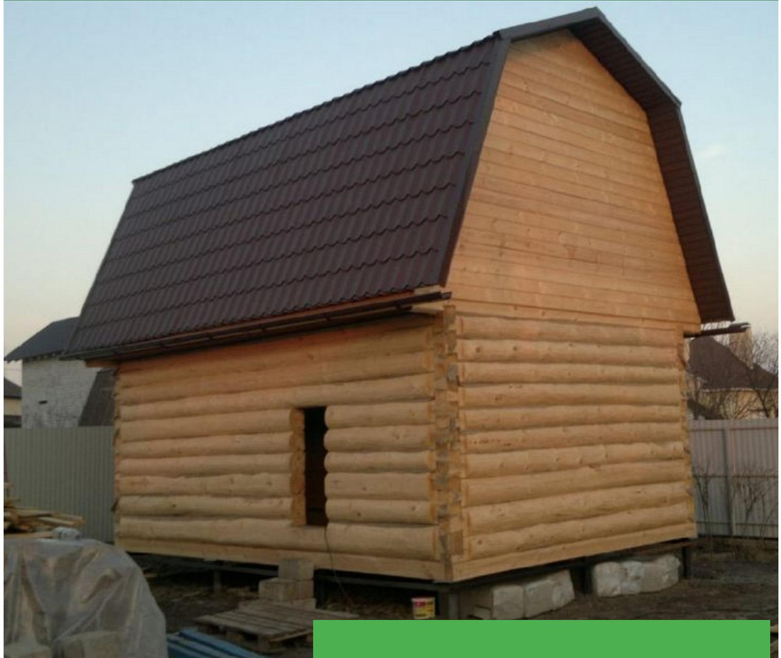
В комплекте: половые лаги, потолочные перекрытия, фронтоны защиты обрезным материалом или вагонкой, крыша кроется рубероидом на время усадки сруба, межвенцовый утеплитель мох, гвозди, рубероид
