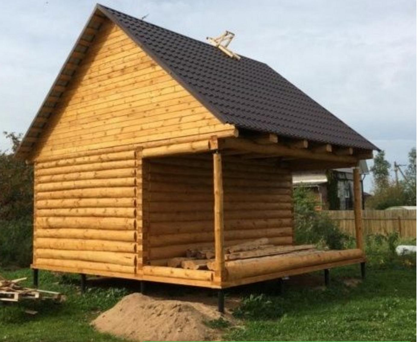
В комплекте: половые лаги, потолочные перекрытия, фронтоны защиты обрезным материалом или вагонкой, крыша кроется рубероидом на время усадки сруба, межвенцовый утеплитель мох, гвозди, рубероид
